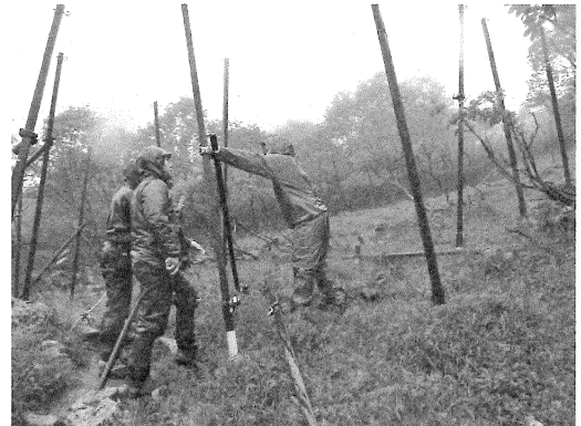
環境省既設箇所の再設置 ↑
