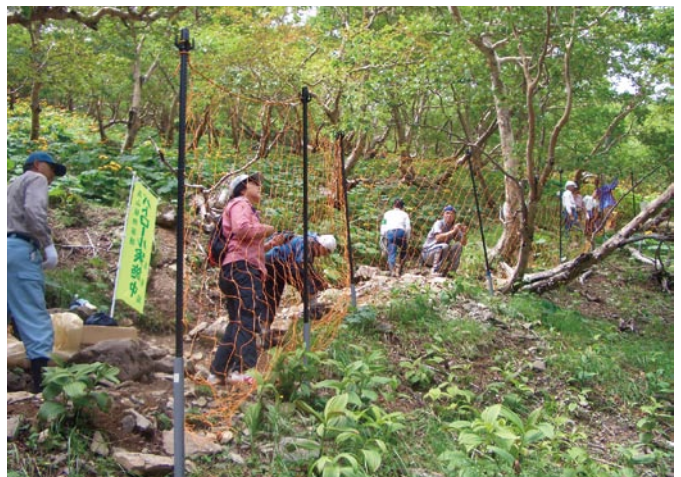
南アルプス食害対策協議会による仙丈ヶ岳馬の背における防鹿柵設置の様子（2008年8月）。写真はいずれも鷗飼一博氏撮影
