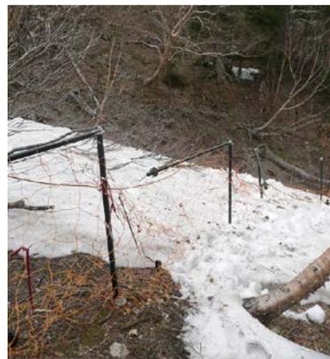
写真2 雪の重みで折れた防護柵の支柱
