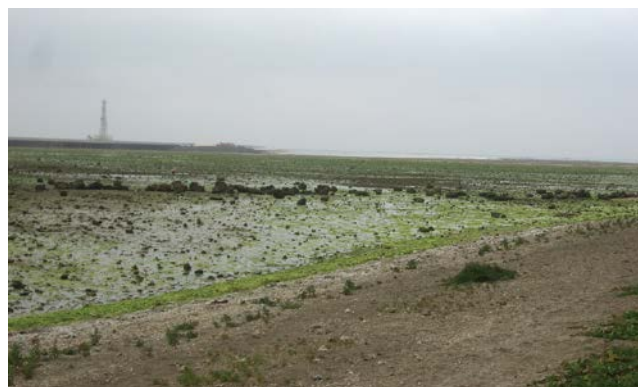
写真2 埋め立て工事が進む泡瀬干潟(撮影：高島)
