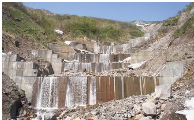
写真1 白山の地すべり地で行われている地すべり対策事業（2015年撮影）
