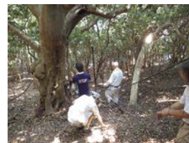
写真4 シカ柵設置作業
