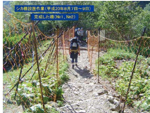
設置された防鹿柵
