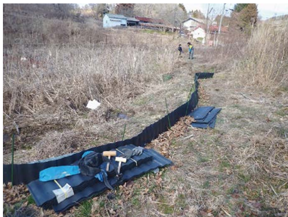
図1 新たに設置した波板
