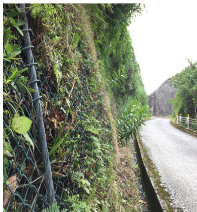
図5 御蔵島の東側を貫く都道。法面に張り巡らされた落石防止用の金網とコンクリート擁壁および全線を走る側溝。植物の下はほぼ全線にわたり金網が張られている（岡撮影）
