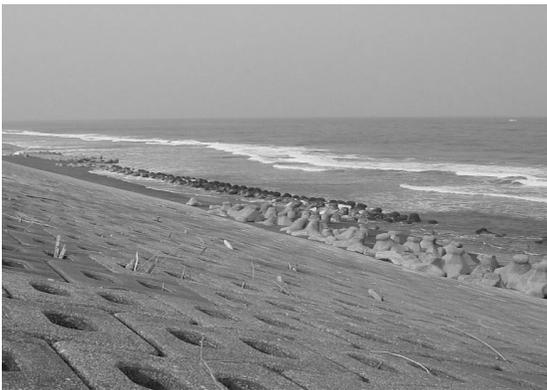
写真1 かつては砂浜だった一ツ葉海岸の緩傾斜護岸と消波ブロックの列
