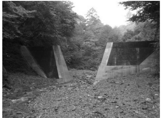
写真1 中央部が撤去された茂倉沢2号堰堤
