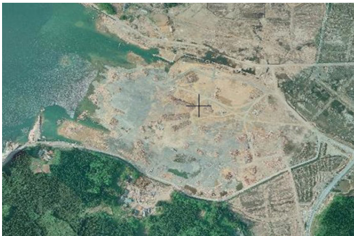
図9 小友浦,被災直後の状況. 被災地周辺の空中写真. 撮影:国土地理院
