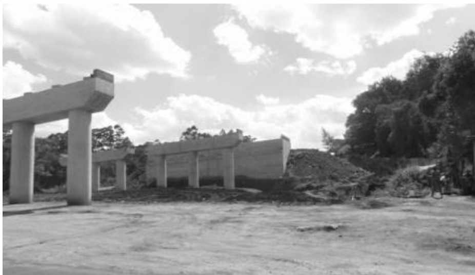
図7 大規模な道路建設
