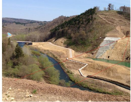
図11 サウルダム建設予定地。わずか幅30m足らずの小さなサウル川に幅300m、高さ50mものダムがつくられる
