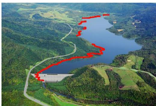
図12 サウルダム建設後のダム湖と魚道予定地。太線で示すようにダム湖に沿って、長大な魚道の建設が進められている
