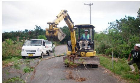
図8 ショベルカーによるギンネム引き抜き。最大級の株が引き抜ける。
