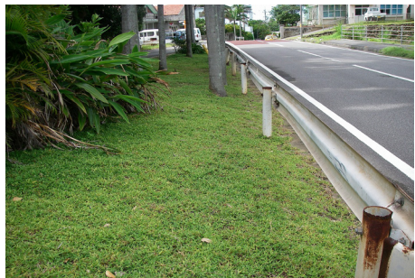
図2 道路沿い平坦地でのクロイワザサの植栽状況，3年後。
