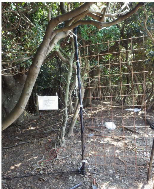
図 13 シカ柵設置作業 6. 山道に設置した出入口。
