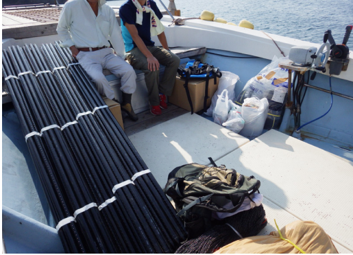
図8 シカ柵設置作業1. 資材を船に積み込んで運搬.
