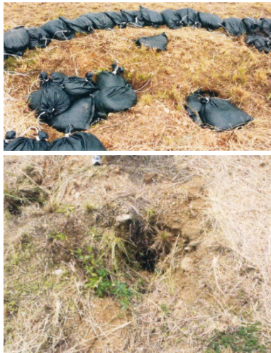
図2 着陸帯でも陥没が発生。2015年5月にはB洞ケイプシステムの流路上の地盤（着陸帯）が陥没した。大雨による地下侵食が原因と考えられる。
