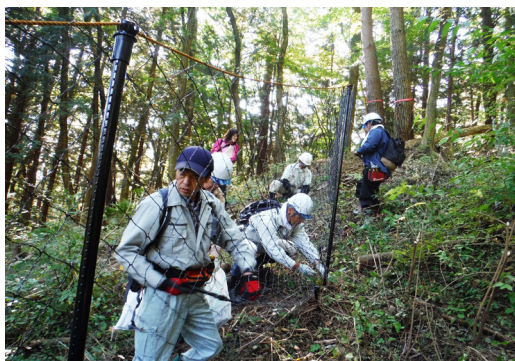
図6 防護柵・誘導柵設置状況。植樹した区域を囲む形で柵を設置し、侵入を防ぎ近くに仕掛けるわな。檻へ誘導するように防護柵を設置した。
