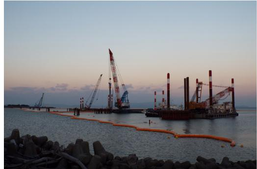
図3 2016年11月から本格的工事が始まった四国横断自動車道(高速道路)の吉野川河口部。全長1696.5mで、川に架かる橋としては国内最長級。完成は2019年度中の予定。
